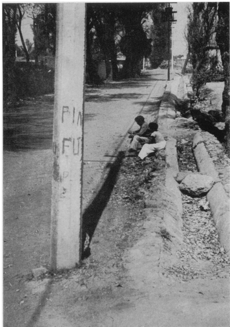
LÁM. II. Principio del caño de desagüe del manantial de Atliliquecan.
